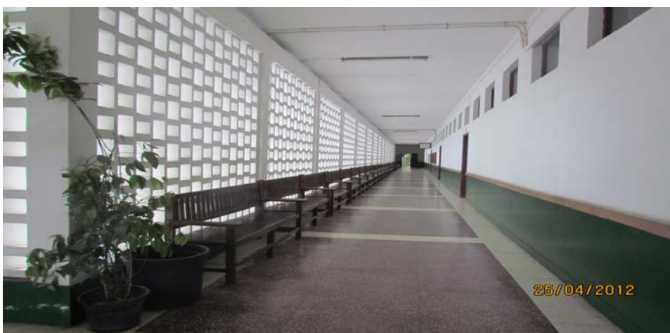
Imagem 6: Edifício da Reitoria - vista geral
